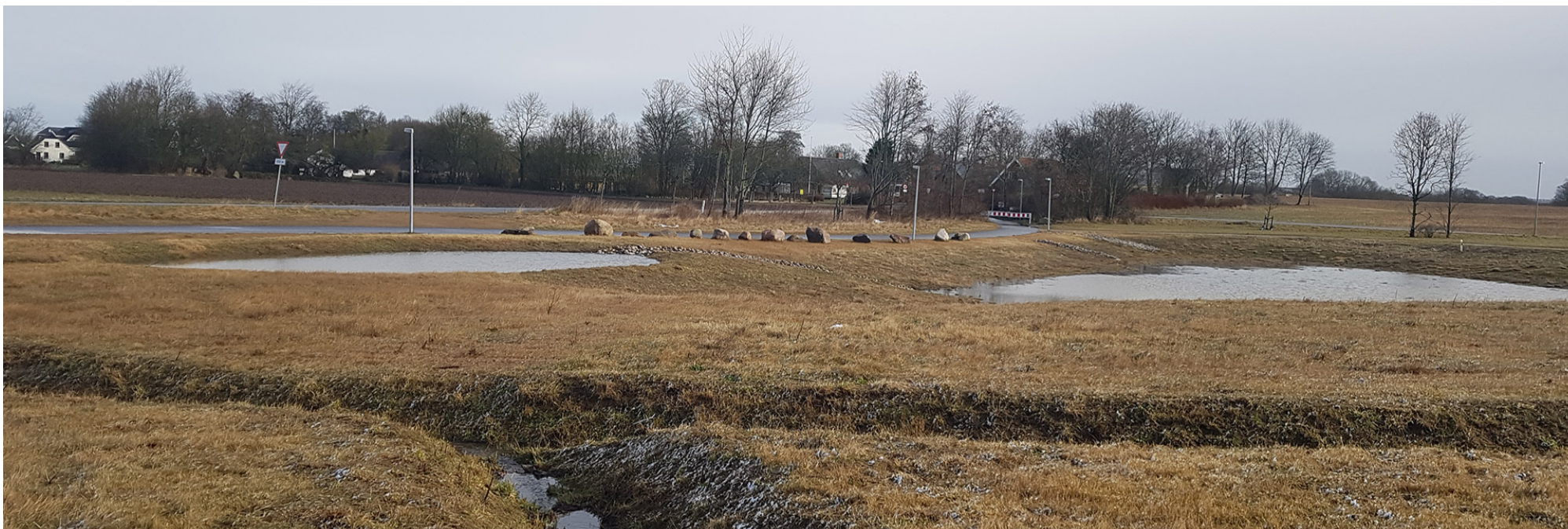
Foto taget i regnvejr af de nyanlagte regnvandsbassiner på Bjergegårdsvej i Hinnerup. Et boligområde, hvor regnvandet primært håndteres på overfladen ved åbne grøfter og vandrender.
